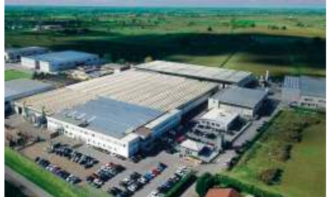
Рис. 1. Главный офис и фабрика Campitello.
